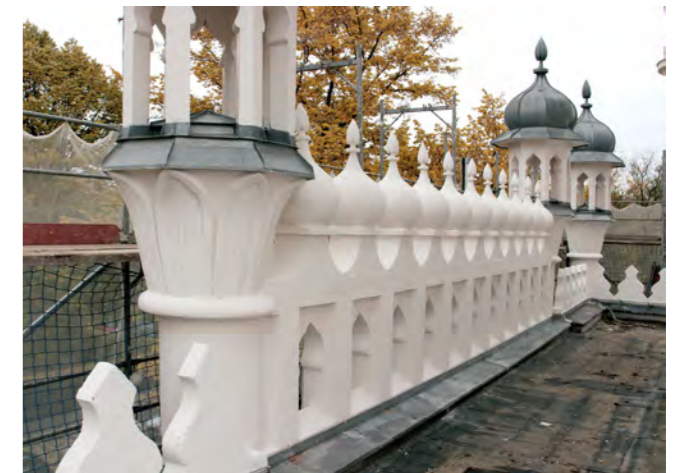
Brüstung oberhalb des Portals nach der Instandsetzung 2016 © D:4
