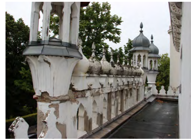
Brüstung oberhalb des Portals vor der Instandsetzung 2016 © D:4
